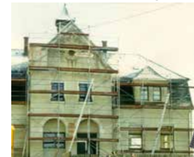
Das frühere Schulhaus Niederstötzingens wird zum Musikerheim umgebaut
