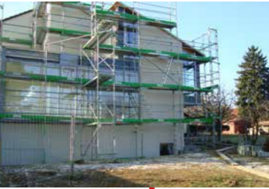
Komplette Renovierung des Schützenkellers sowie des Schießraums mit Anbau der heutigen Küche
